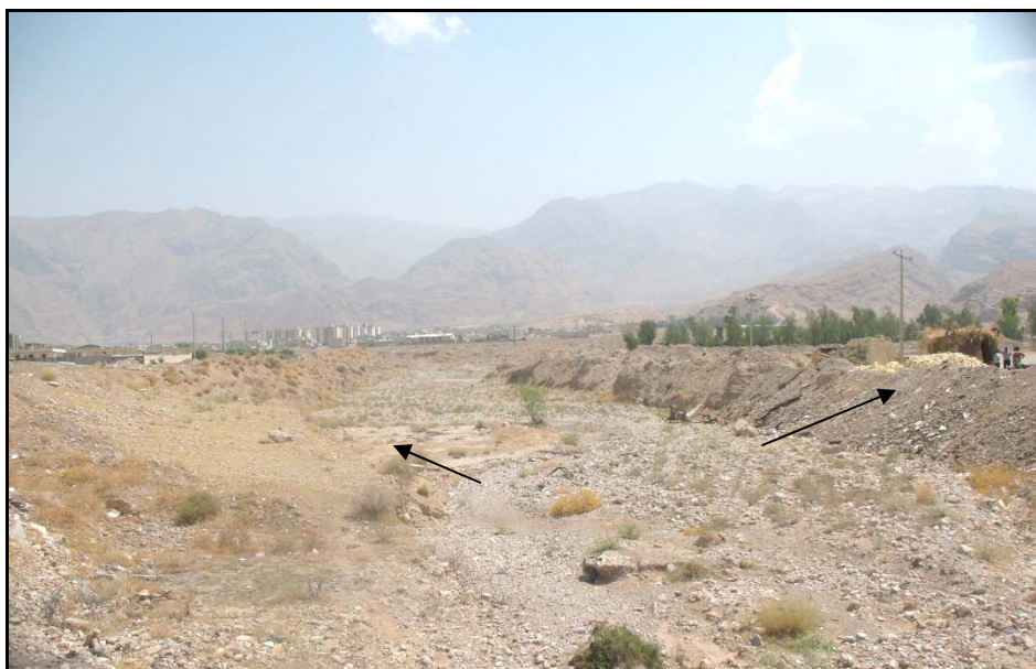
شکل ۷- ایجاد خاکریز مصنوعی در حاشیه رودخانه کتویه
