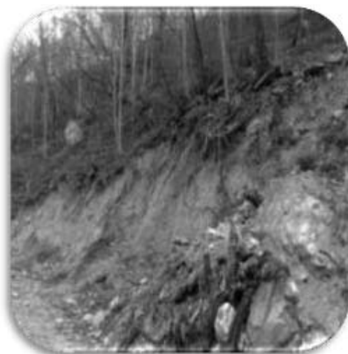
شکل ۷- نمایی از اشکال فرسایشی ناشی از جاده
