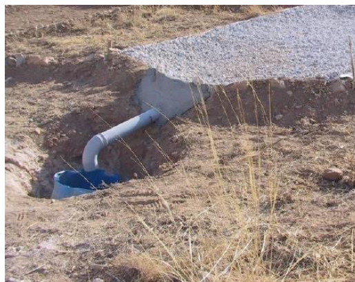
شکل ۲: سامانه‌ی سطوح آبگیر باران غیرقابل نفوذ
