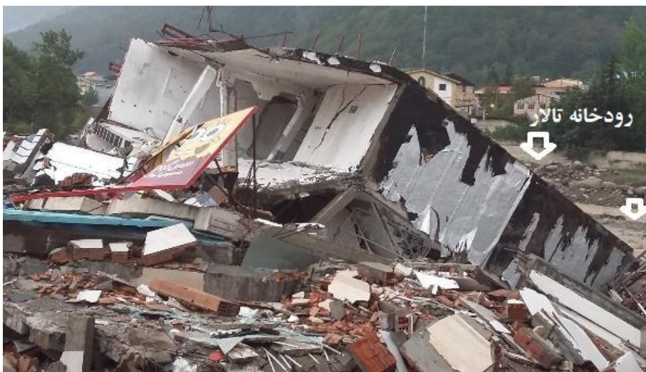
شکل ۸: نمایی از ساختمان شش طبقه و مغازه تخریب‌شده در حریم بیست متری رودخانه شهر زیرآب (سیل ۱۳۹۴/۴/۲۸)
