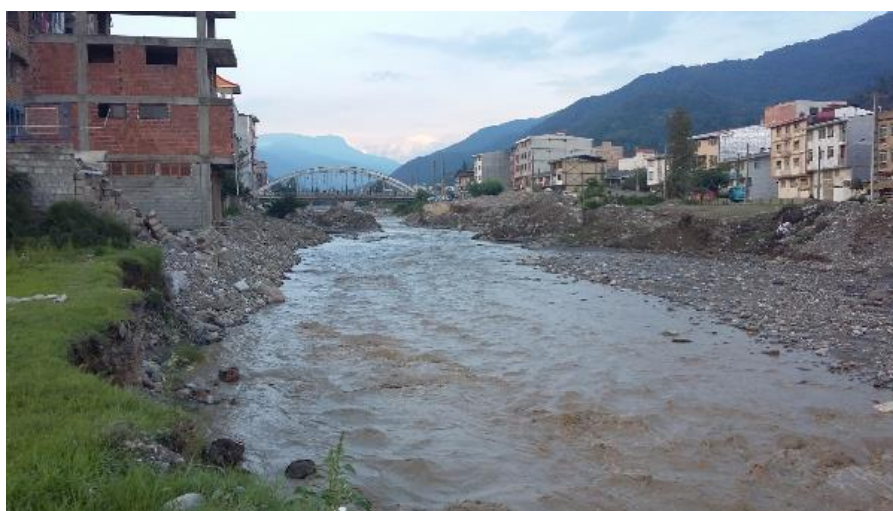
شکل ۹: بالادست پل شهید طباطبایی در شهر پل سفید و خانه‌سازی در بیست متری حریم رودخانه
