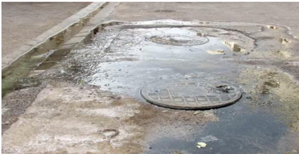
شکل ۳: نمونه‌ای از مسدود بودن منهول‌های کانال‌های ساخته شده
