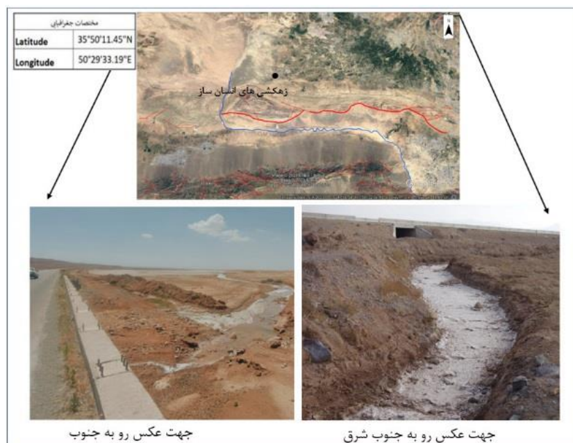
شکل ۹- کانال‌های زهکشی در حاشیه بزرگراه جدید احداث
