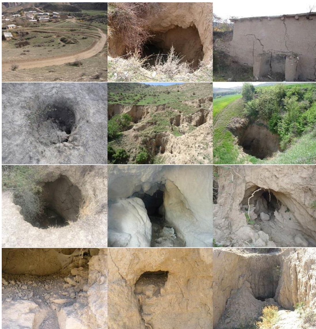
شکل ۲: تصاویری از موقعیت روستا، فرسایش تونلی و فروچاله‌ها
