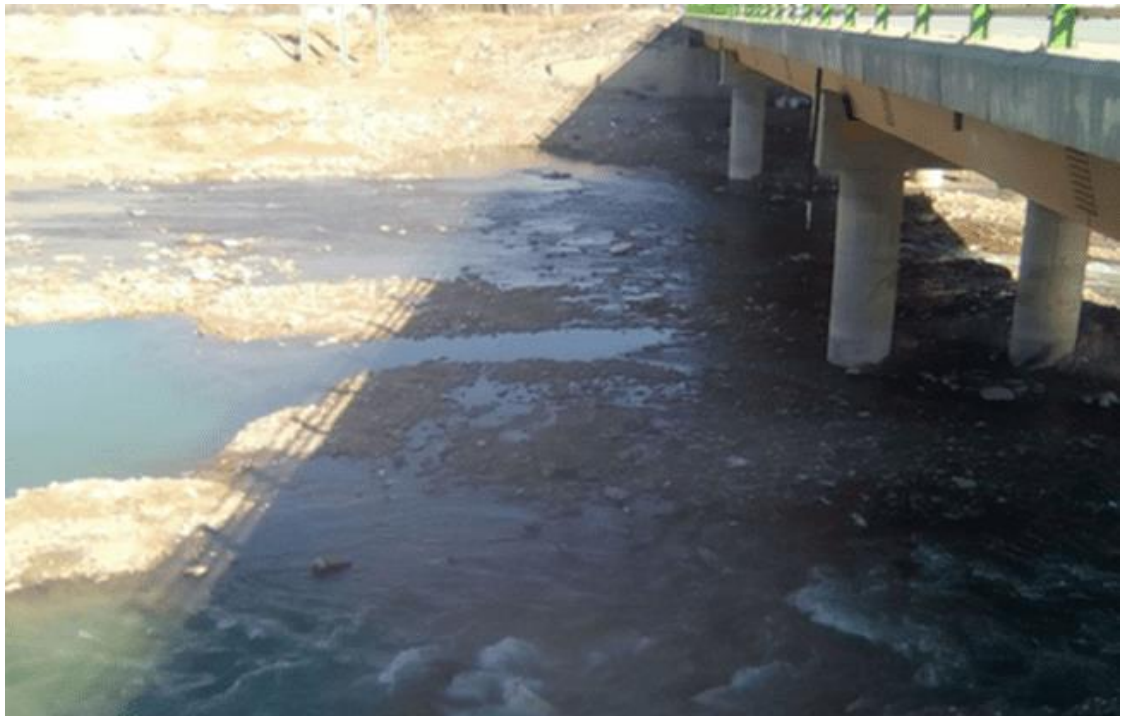
شکل ۶: ته‌نشینی رسوبات در محل پل کمربندی غربی شهر کرمانشاه و تشکیل جزایر رسوبی در بازه ۱ (عکس از نگارندگان)
