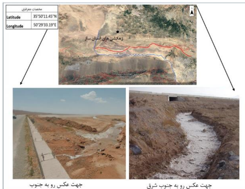
شکل ۹- کانال‌های زهکشی در حاشیه بزرگراه جدید احداث
