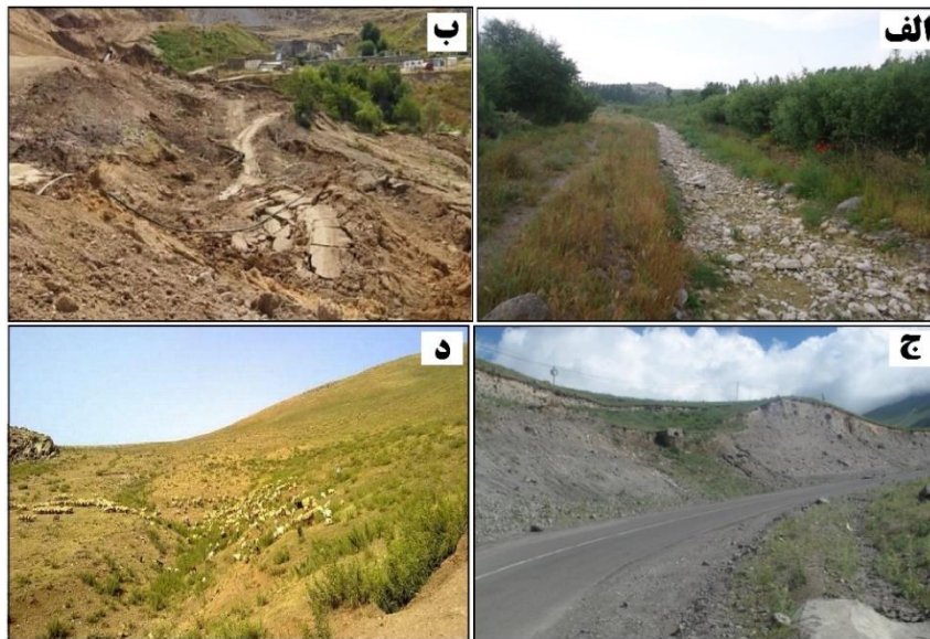
شکل ۹: الف: نمایی از تصرف در بستر رودخانه خیابوچای با توسعه اراضی کشاورزی و باغات. ب: پروژه انتقال آب به مناطق روستایی و فرسایش و لغزش دامنه به دنبال آن در ایلاملو. ه: زیربری و از بین بردن پاشنه دامنه به دنبال احداث جاده در مسیر ارتباطی مشکین‌شهر به روستای موئیل. و: اجرای بی رویه دام‌های روستاییان در سطح مراتع شهرستان
