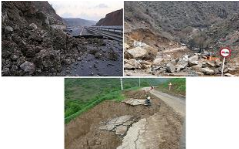
شکل ۷: تصاویری از نمونه زمین‌لغزش‌های رخ داده در مسیر ارتباطی خرم‌آباد-زال
