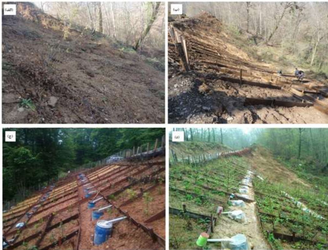
شکل ۴: نمایی کلی از روند اجرای کار در منطقه‌ی مورد مطالعه. الف: سطح شیب‌دار در دامنه‌ی خاک‌ریزی پیش از اعمال تیمار، ب: آماده‌سازی بستر و کرت‌بندی برای اعمال تیمارهای حفاظتی و کاشت نهال، ج: نصب لوله‌ها و بشکه‌های جمع‌آوری رواناب و رسوب، د: نمایی از منطقه در انتهای دوره‌ی مورد مطالعه
